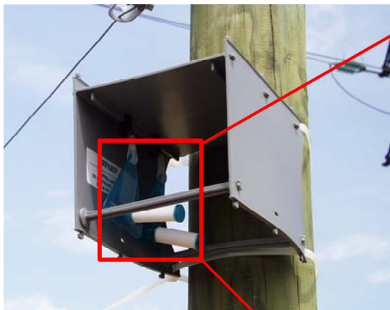
Figure 1 : Echantillonneurs passifs de BTEX installés à l'intérieur de l'abri de protection
